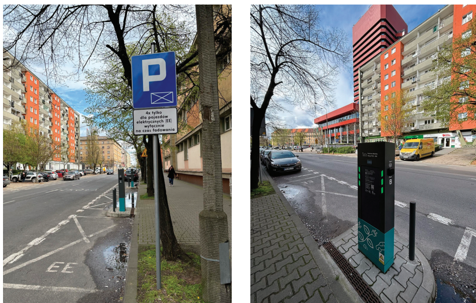
Rys. 3. Oceniana stacja do ładowania Źródło: Fot. J. Olszewska i Z. Misiek
