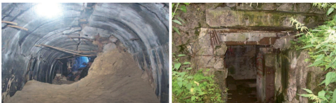
Fot. 4. Schron bojowy Pz.W866 (2015 r.) (fot. R. Wiśniewska)
