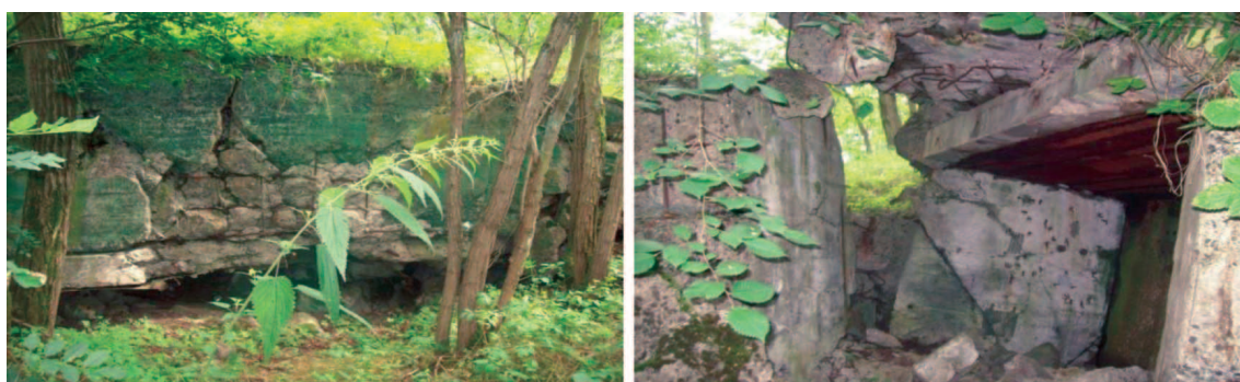
Fot. 2. Schron bojowy Pz.W.864 (2015 r.) (fot. R. Wiśniewska)
