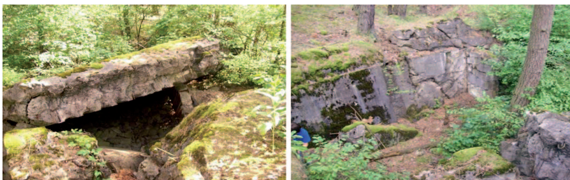
Fot. 8. Schron bojowy Pz.W.874 (2015 r.) (fot. R. Wiśniewska)
