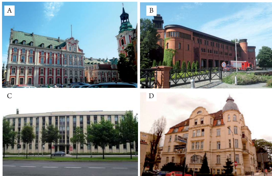
Fot. 1. Budynki administracji publicznej zapewniające duże poczucie bezpieczeństwa (fot. K. Gogolewska)
