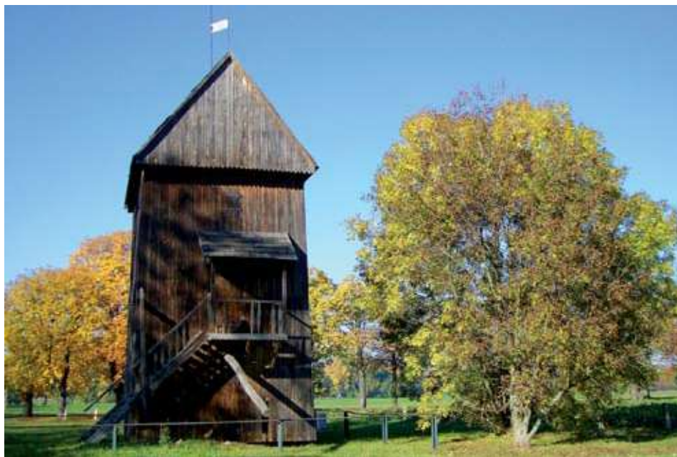
Fot. 18. Wiatrak „Franciszek” w Pępowie (fot. M. Krych)
