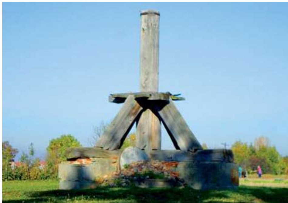
Fot. 1. Pozostałość wiatraka w Bodzewie – koziół (fot. M. Krych)
