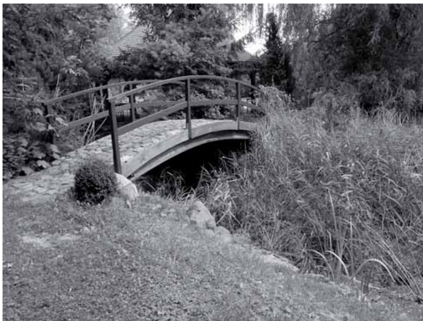
Fot. 1b. Kamienny mostek w północnej części zbiornika nr 1 (fot. M. Pajchrowska)
