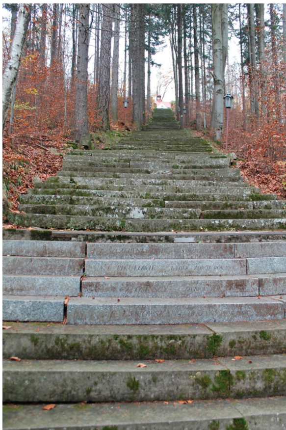
Rys. 7. Radochów „Cierniak” — prowadzące na wzniesienie kalwaryjskie granitowe stopnie z imionami i nazwiskami fundatorów
