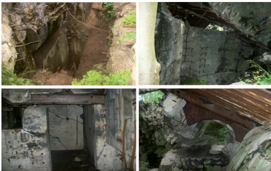
Fot. 1. Schron bojowy Pz.W.865 (2015 r.) (fot. R. Wiśniewska)
