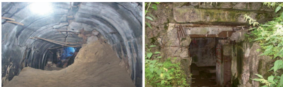
Fot. 4. Schron bojowy Pz.W866 (2015 r.) (fot. R. Wiśniewska)
