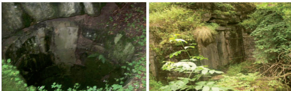
Fot. 6. Schron bojowy Pz.W.868 (2015 r.) (fot. R. Wiśniewska)
