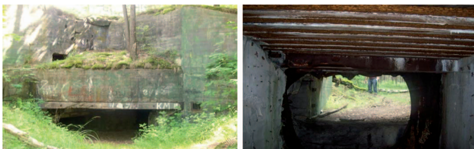
Fot. 7. Schron bojowy Pz.W.875 (2015 r.) (fot. R. Wiśniewska)
